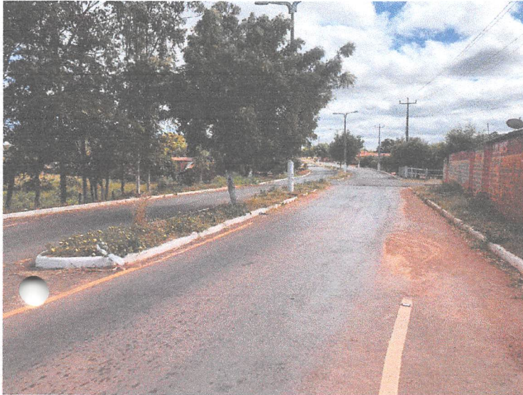
AVENIDA PRINCIPAL DO BAIRRO FAVEIRA
