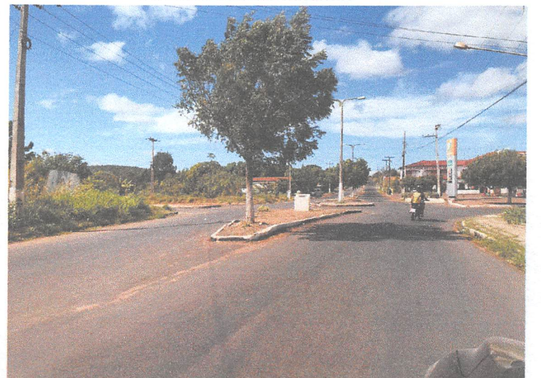
AVENIDA PRINCIPAL DO BAIRRO FAVEIRA
