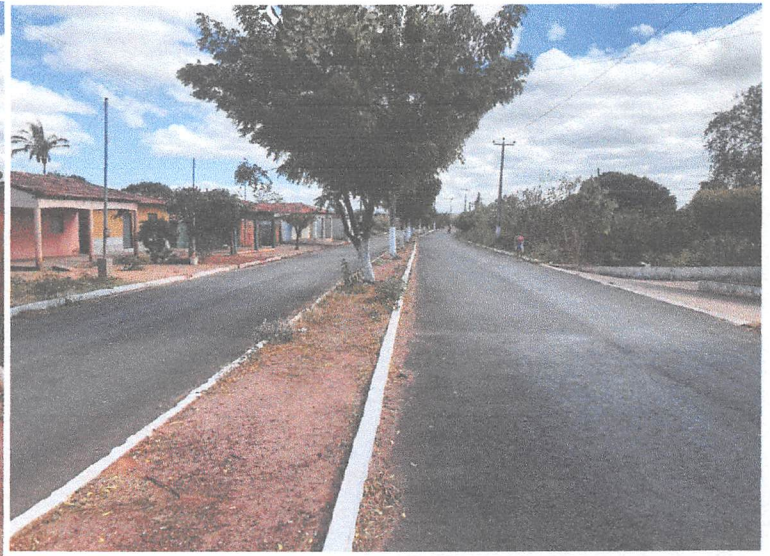
AVENIDA PRINCIPAL DO BAIRRO FAVEIRA
