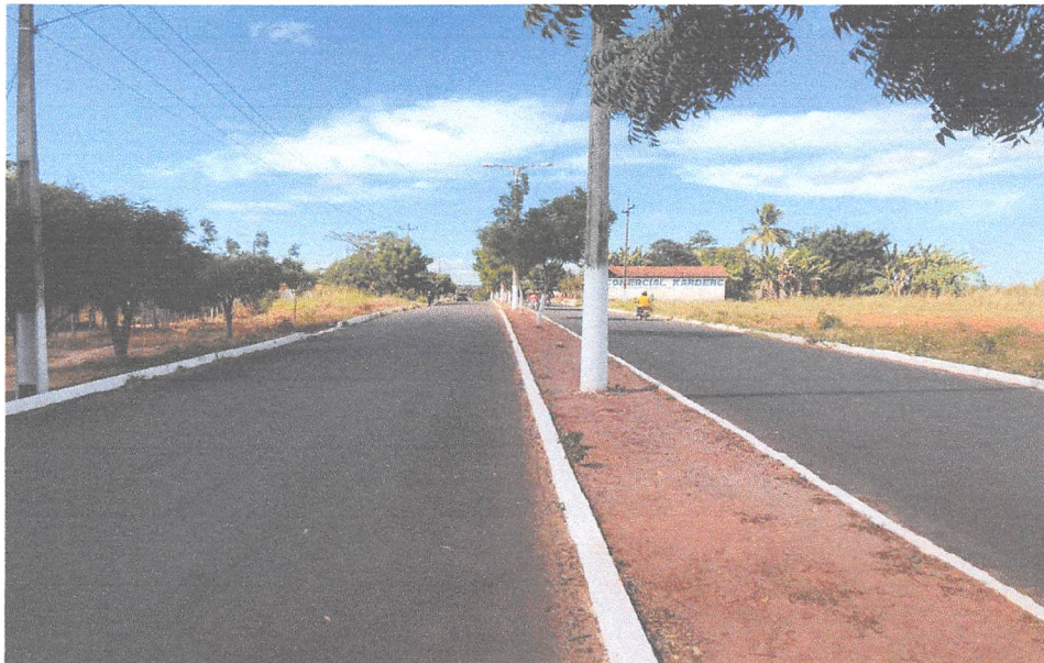
AVENIDA PRINCIPAL DO BAIRRO FAVEIRA
