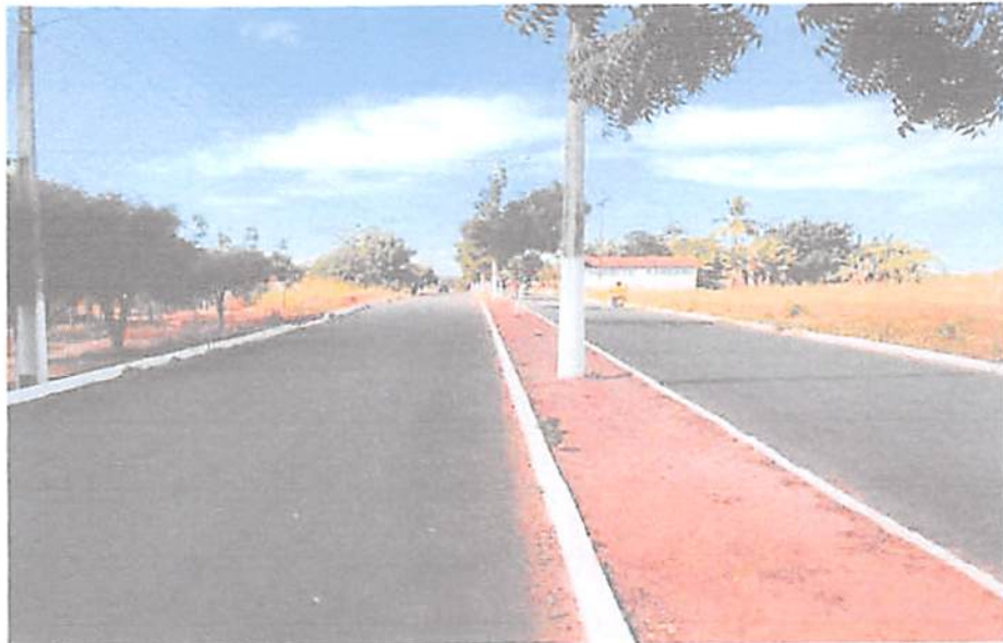
AVENIDA PRINCIPAL DO BAIRRO FAVEIRA
