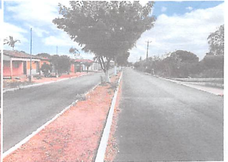
AVENIDA PRINCIPAL DO BAIRRO FAVEIRA
