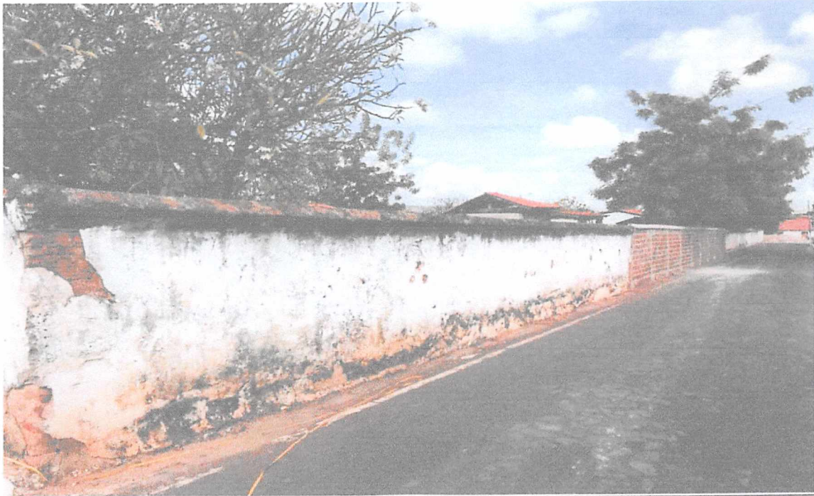
Muro Lateral Direita
