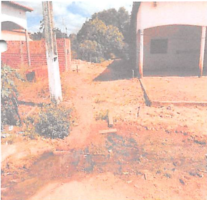
TRECHO 1 DA RUA DO SARDINHO
