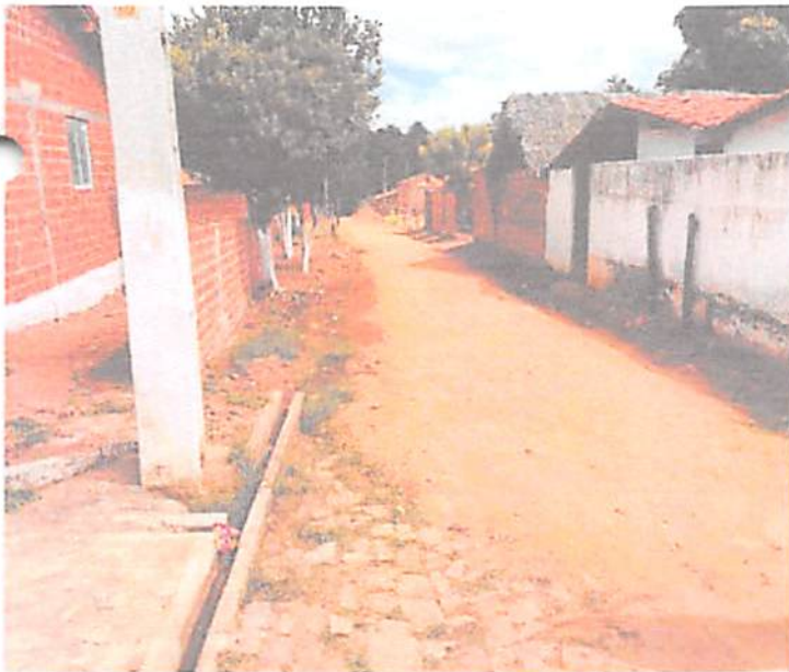
TRECHO DA RUA DO PRADO
