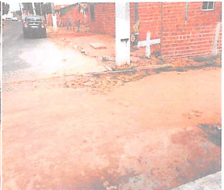
TRECHO DA RUA DO PRADO
