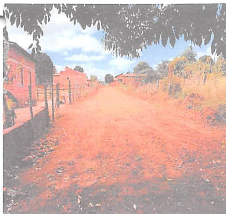
TRECHO DA RUA DO PRADO
