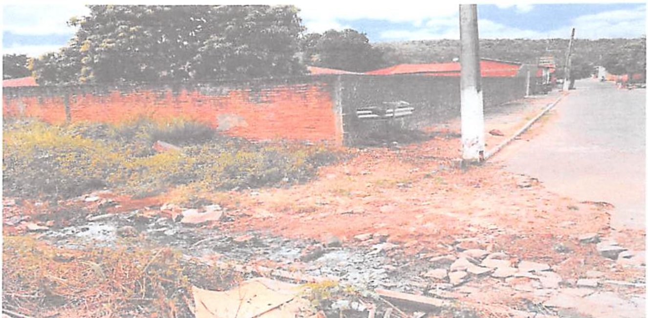
TRECHO 2 DA RUA DO SARDINHO
